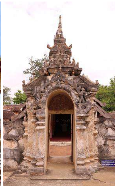
ซุ้มประตูโขง วัดไหล่หินหลวง อำเภอเกาะคา
