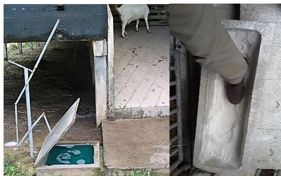
ภาพที่ 31 บ่อน้ำยาฆ่าเชื้อ (ภาพ ก) และอ่างใส่ปูนขาว (ภาพข) สำหรับฆ่าเชื้อที่ติดมากับรองเท้า
